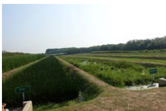
写真11 王室水質浄化施設
